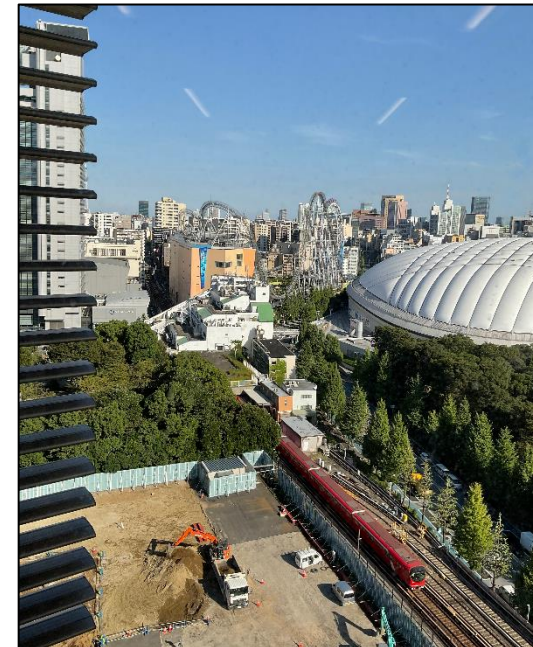
新事務室から望む改修工事の様子
